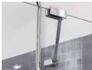
Cristal fijo con barra de sujeción de acero inox.
