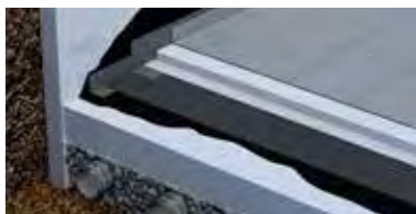
Solera con barrera de radón Sistema RAD3 180-40 P Elast
